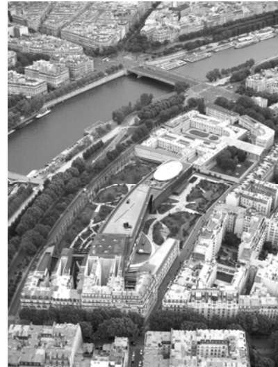
Blick vom Eiffelturm auf den in Bildmitte sichtbaren lang gestreckten Museumsneubau.
