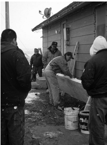
Henry Red Cloud leitet einen workshop zur Installation einer thermischen Solarheizunganlage.
