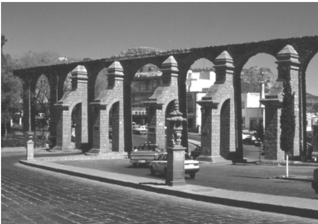
Abb. 3: Blick auf den Aquädukt.
