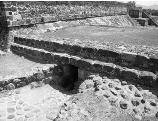
Abb 5: Tunnel, der als Kanal oder Leitung unter der ersten Böschung verlief. Durch ihn wurde Wasser ins erste Becken geleitet.
