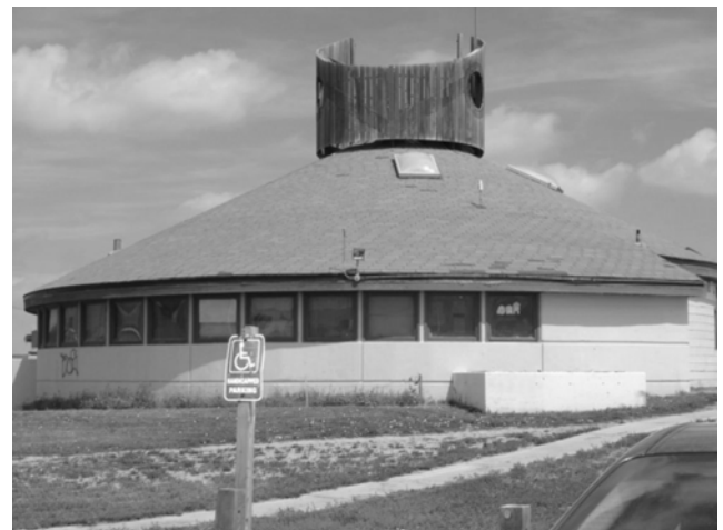
Typisches Rundhaus der Gemeinde, Pine Ridge, als Beispiel für die moderne Lakota-Architektur.
